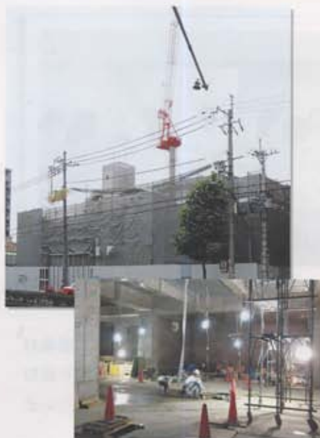
現在、新病院建設工事は全工程の約25%のところまで事故もなく順調に進んでいます。
